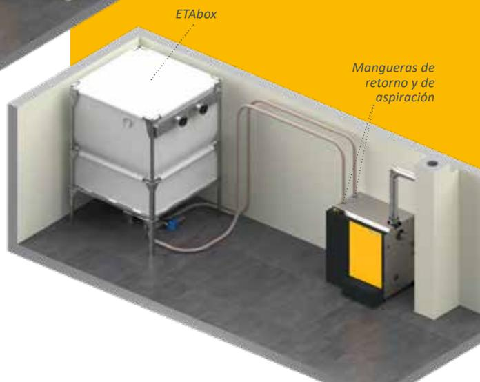
Con el sistema de extracción de combustible E3 topo se puede vaciar casi completamente el espacio del depósito y se eliminan las rampas de madera.
