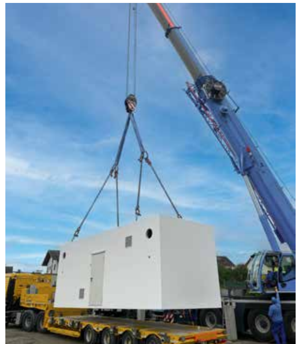
Anlieferung mittels Spezial- oder Tiefladerfahrzeug
